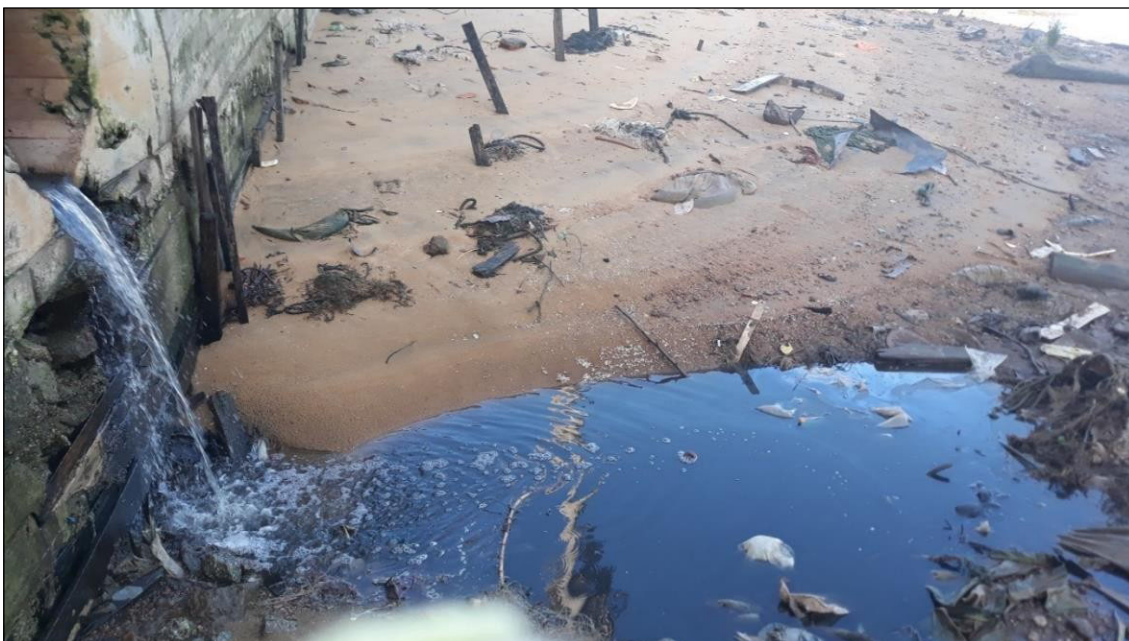
Figura 10. Lançamento de efluentes domésticos na orla fluvial do rio Oiapoque/AP.
