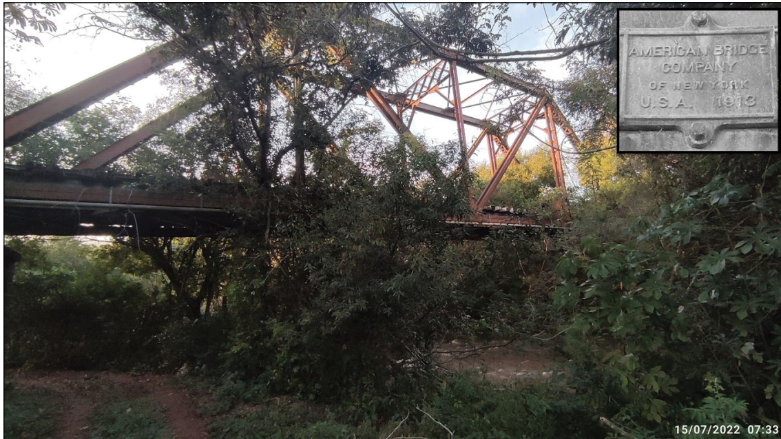
Figura 2. Ponte Metálica sob o Rio Pari-Veado, próximo ao Distrito de Sussui. No detalha, no canto superior a direita, o nome da empresa e a data de fabricação.
