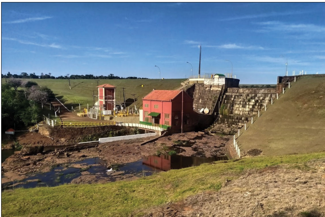
Figura 3. Usina Hidrelétrica no Rio Pari-Veado, foto tirada em agosto de 2021, período marcado pela estiagem e reduzida vazão pelo vertedouro.
