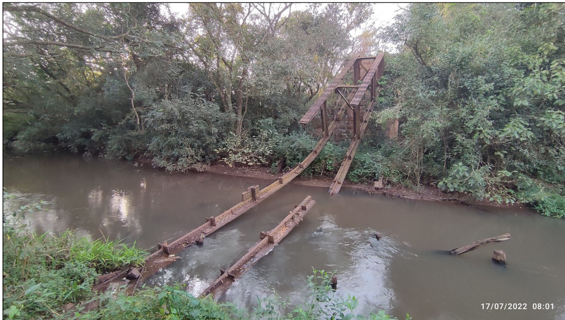
Figura 1. Ponte Metálica sob o Pau D' alho.
