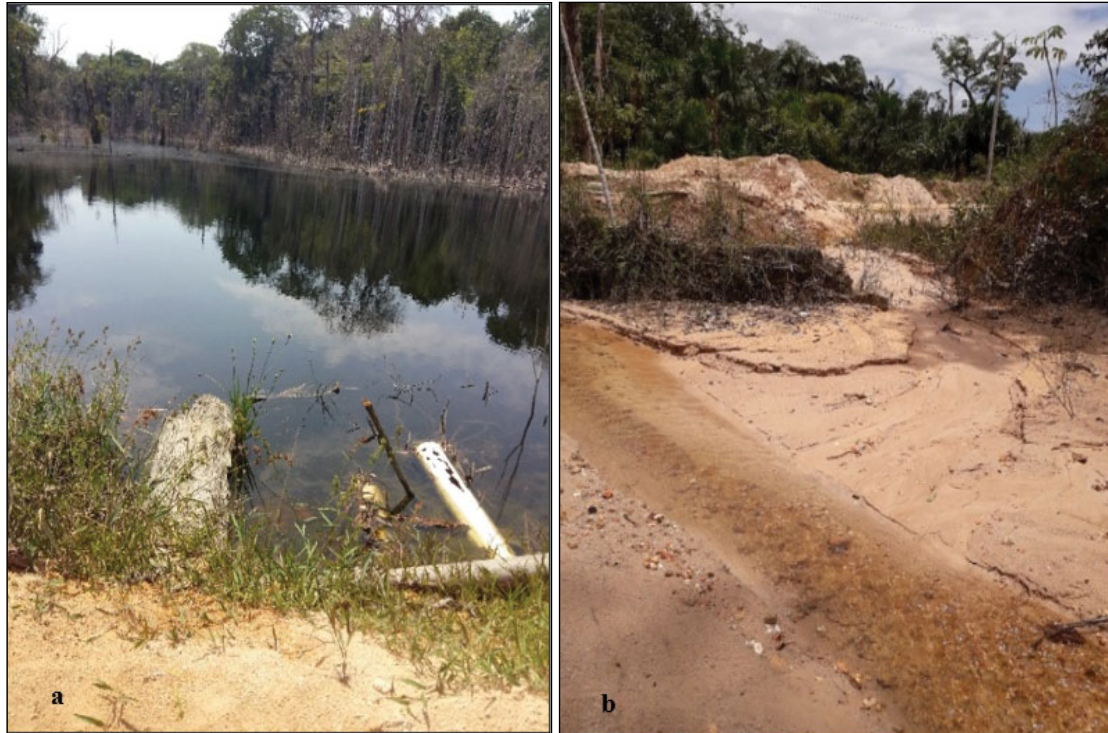
Figura 5. Vista parcial de um igarapé a montante (a) e jusante (b), em um trecho do ramal. (a) Área represada com a presença de árvores mortas (“paliteiros”). (b) Processo de assoreamento, causando pouca vazão de água devido à execução de drenagem inadequada.
