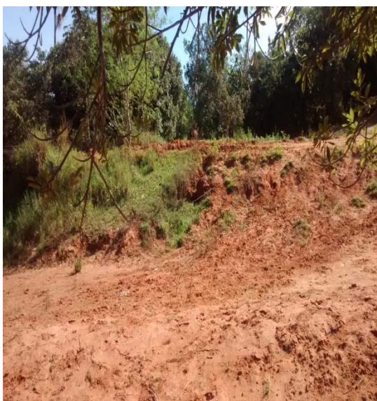
(A) Presença de processos erosivos
