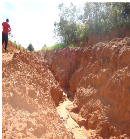
(B) Presença de processos erosivos, ravinamento
