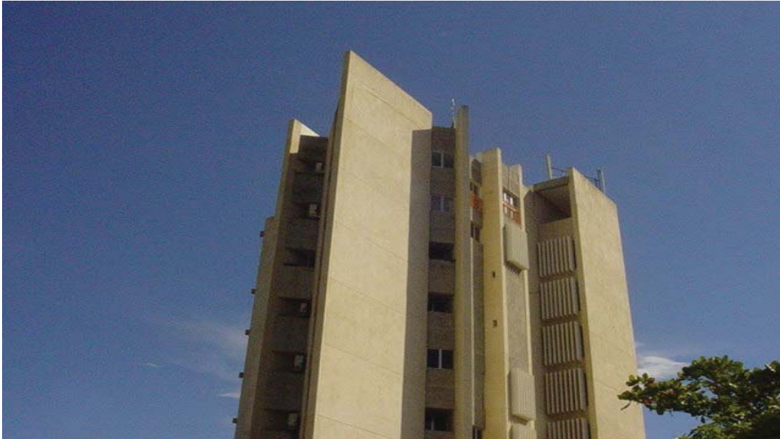
Foto 2: Edifício Sede do GPZ na cidade de Tete – Região do Vale do Zambeze Fonte: Do Autor, 2006
