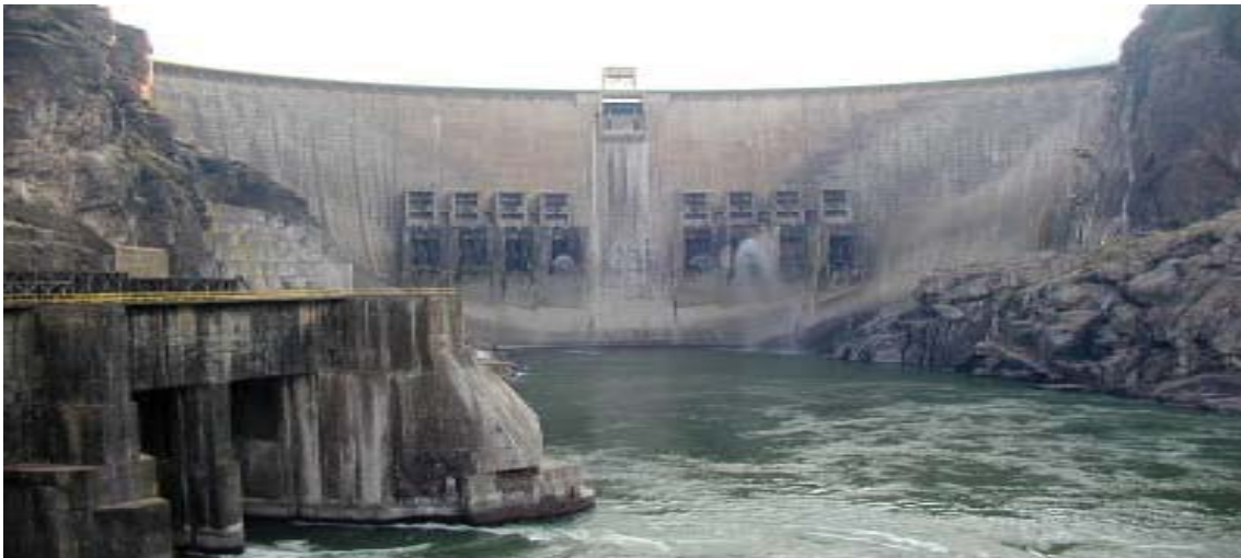
Foto 1: Barragem de Cahora Bassa, uma externalidade à produção energia Fonte: GPZ, 2006. Pesquisa: MUNGÓI, C 2007
