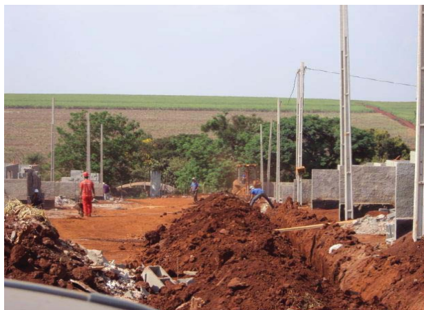
Foto 4: Construção dos conjuntos habitacionais Ourinhos H e I, Ourinhos, 2012. Fonte: Ferreira Dias, 2012.
