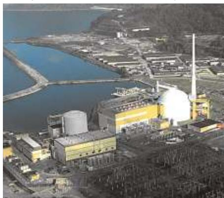
Figura 2: As usinas nucleares de Angra I e Angra II localizadas a beira mar possuem riscos de perdas em caso de eventos extremos de marés, mas são protegidas naturalmente pela baía e pelas barreiras construídas.
