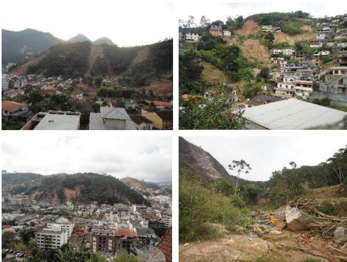
**Figura 3.** Três áreas densamente ocupadas em Nova Friburgo que sofreram grandes deslizamentos em 2011, ocasionando muitas mortes. Na foto abaixo a esquerda, se observa a cicatriz de um grande deslizamento ocorrido à época na bacia do Córrego d'Antas.
