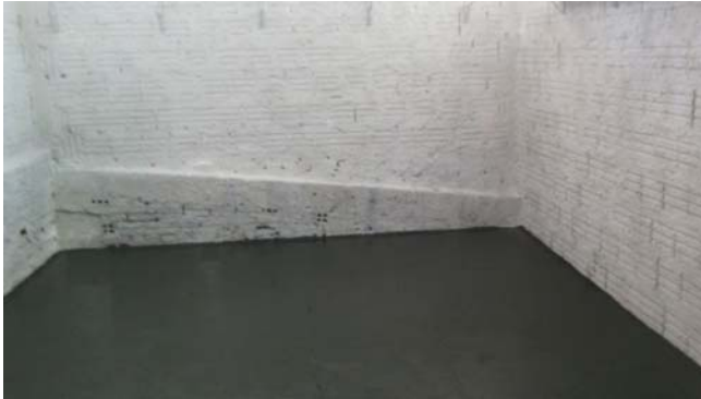
Figura 2. Almoxarifado de tintas após a pintura do piso e das paredes e eliminação total das sujeiras do local.
