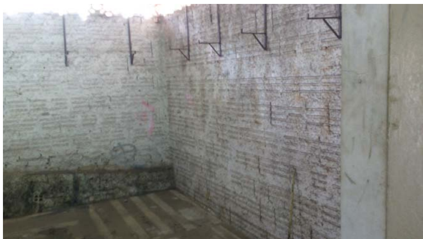
Figura 1. Almoxarifado de tintas antes das atividades de limpeza e pintura.
