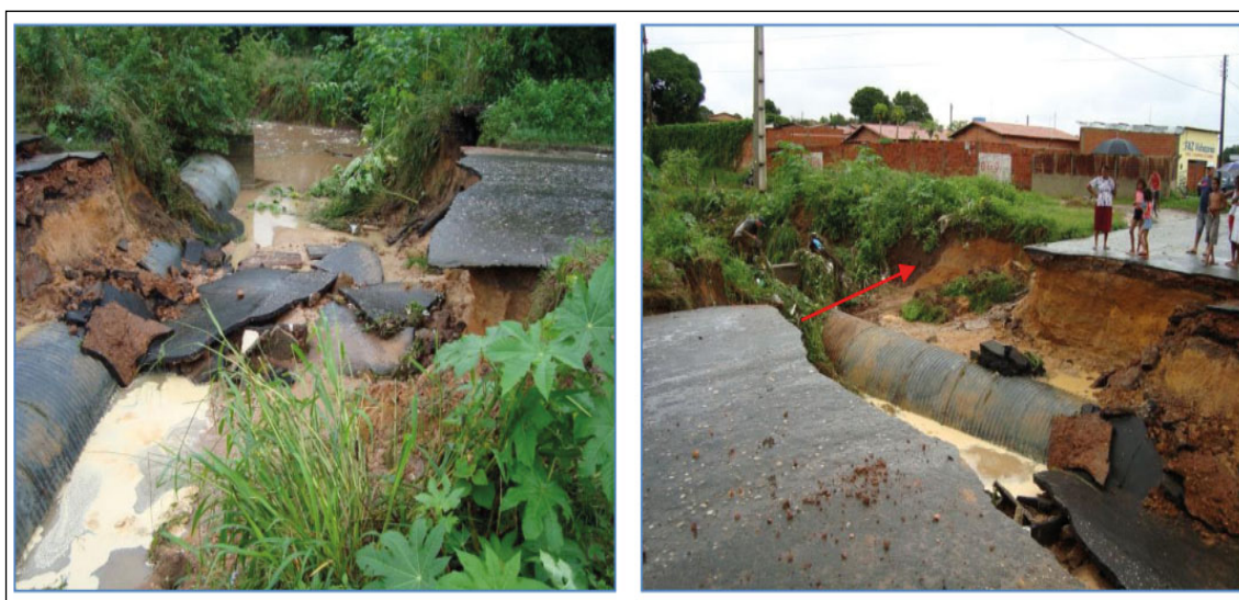
Figura 3. Erosão Hídrica em bueiro rompido na Rua Celso Pinheiro.
