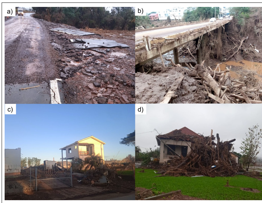
Figura 8. Destruições associadas a enxurradas: (a) asfalto arrancado da estrada pela força da água em Colinas; (b) ponte parcialmente destruída em Roca Sales; (c) casa totalmente desestruturada pela enxurrada em Lajeado; e (d) casa totalmente desestruturada pela enxurrada em Colinas.
